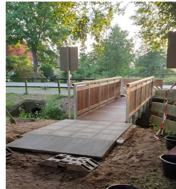
Es wird gearbeitet, Brücke am Spielplatz Mühlenstraße
